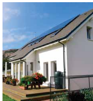
Nyt hus i Skotland (UK)
